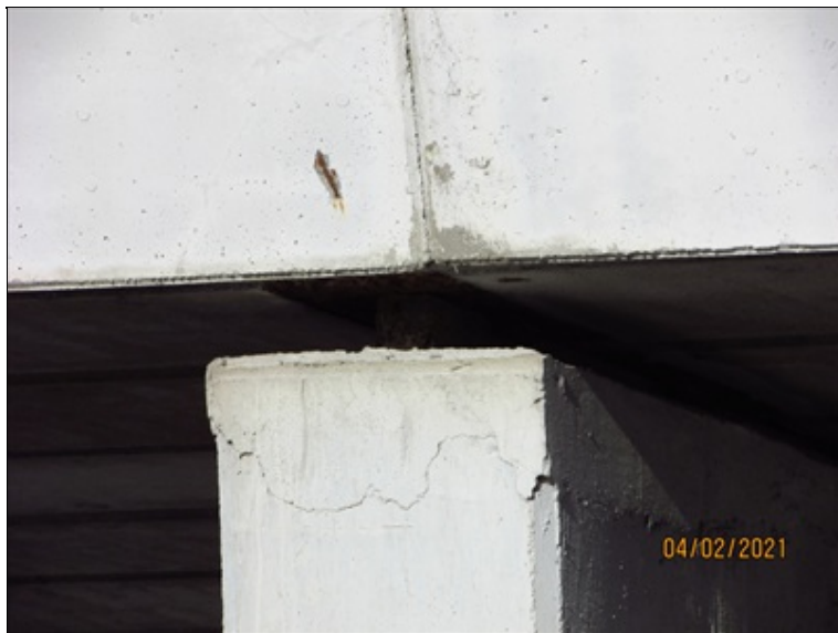
Ocelové kolejnicové ložisko na P3
