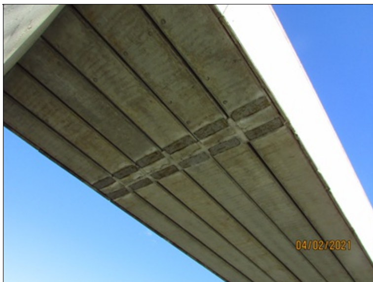
Spodní líc nosné konstrukce, 2. pole. Provizorní kloub za P2 : zabetonované ocelové plechy korodují.
