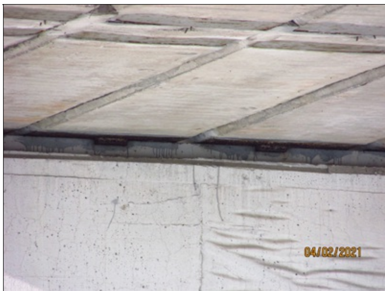
Ocelové kolejnicové ložisko na P3
