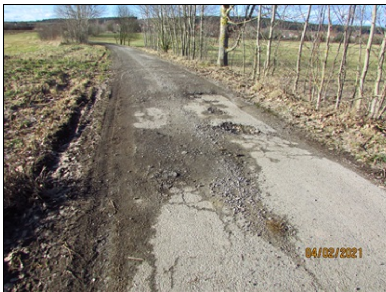
Porušený kryt místní komunikace za mostem.
