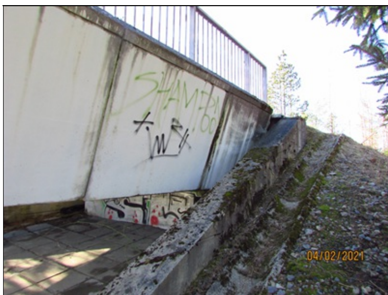
Levé křídlo OP1 : lokálně trhliny, degradovaný beton.
