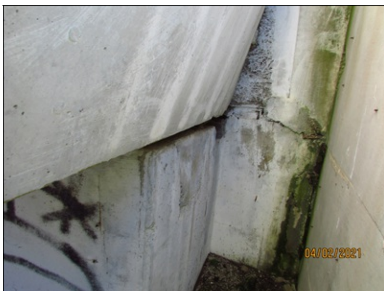
OP4 vpravo : v závěrné zídce je zabetonovaná heraklitová deska, závěrná zídka - prokreslena vodorovná pracovní spára, prokreslena pracovní spára mezi dobetonováním pod kolejnicovým ložiskem a žlb. úložným prahem
