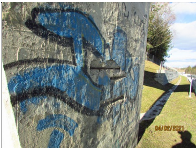
P2 : odpadá krycí vrstva betonu, obnažená výztuž koroduje
