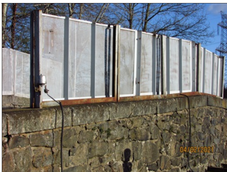
Protidotyková zábrana, začínající koroze
