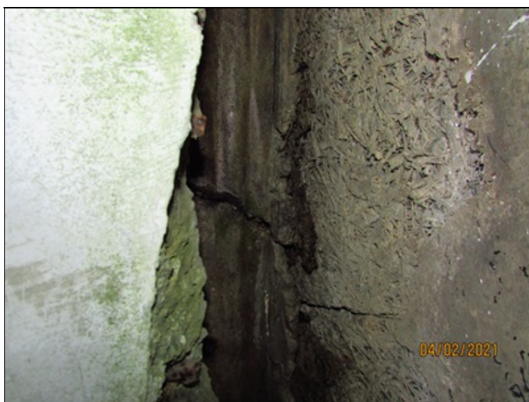
Monolitické dobetonování čel nosníků nad OP1 : odprýsknutý beton, obnažená výztuž koroduje. Závěrná zídka : zabetonovaná heraklitová deska, prokreslena vodorovná pracovní spára.
