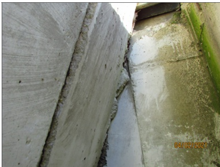
Monolitické dobetonování čela nosníků na OP4 vpravo je separované
