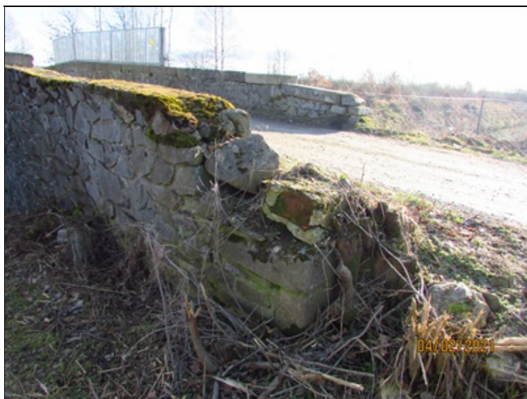
Pravé a levé křídlo, parapetní zídky OP1 : kamenné zdivo na konci je porušené.
