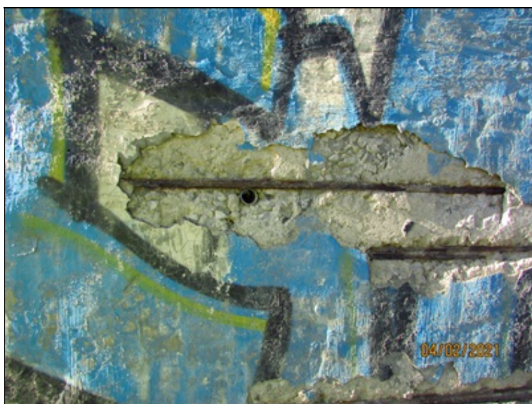
P2 : odpadá krycí vrstva betonu, obnažená výztuž koroduje, lokálně štěrková hnízda
