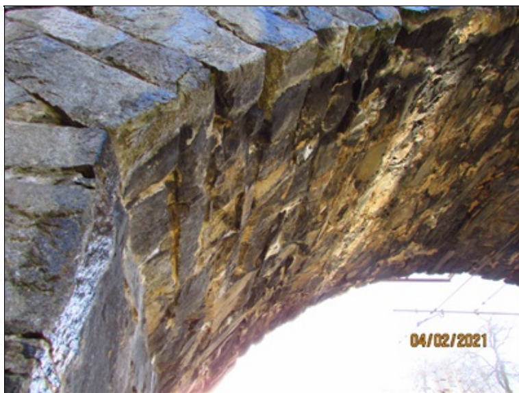
Spodní líc nosné konstrukce. Patrné prosakování vody
